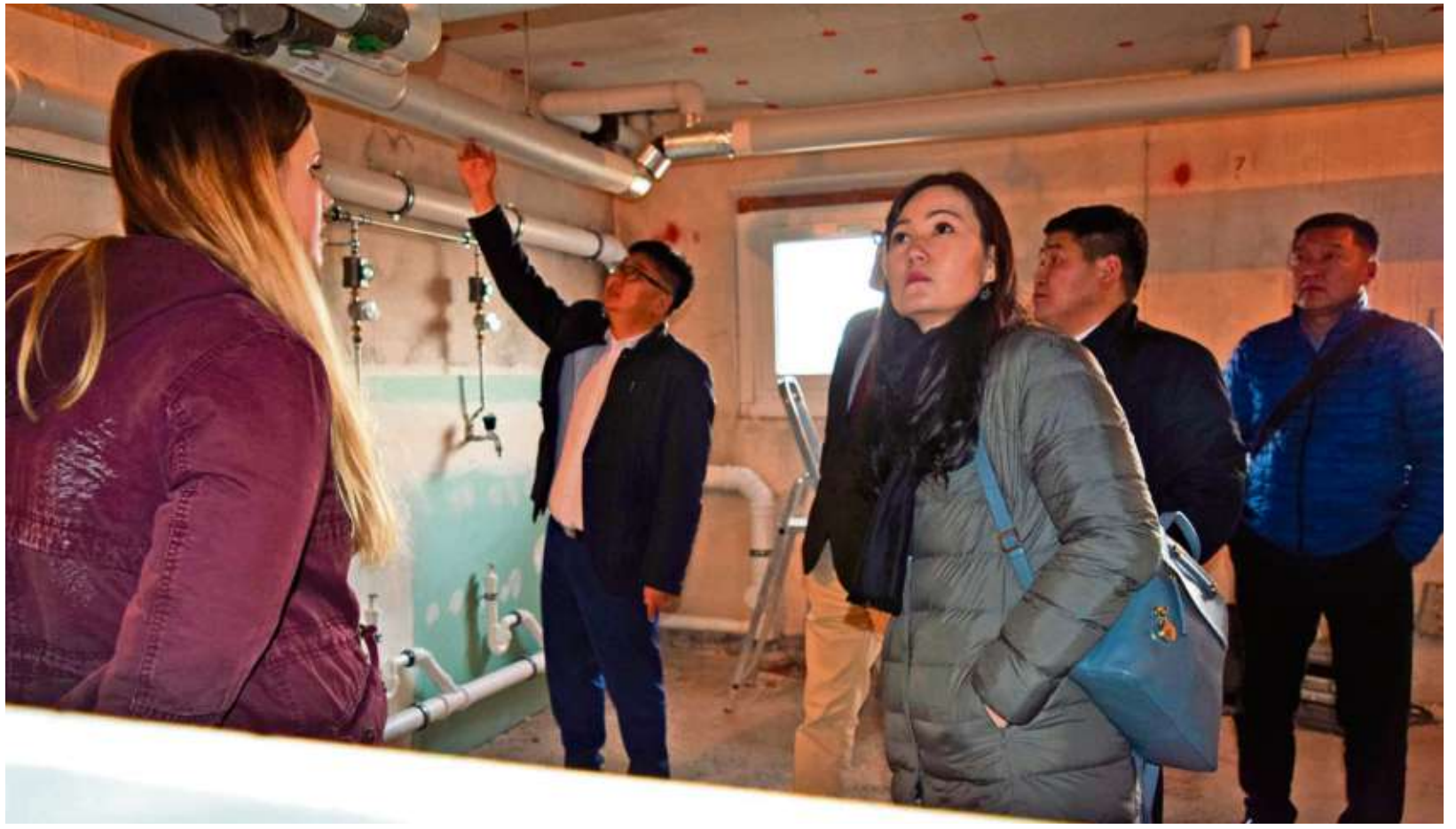
Zusammen mit Wbf-Mitarbeiterin Alicia Schremmer (links) besichtigen die Gäste aus der Mongolei einen fast fertig sanierten Aufgang in der Neuhäuser Prachtitzer Straße, um sich ein Bild von den derzeitigen baulichen Standards zu machen.
